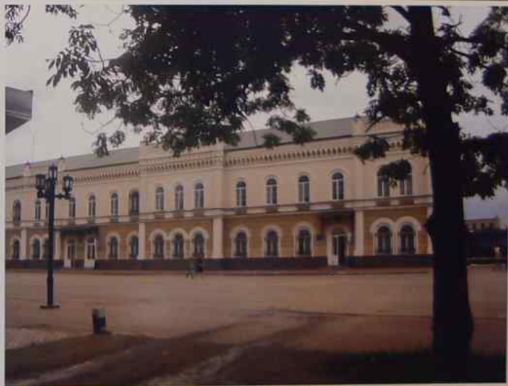
Dworzec kolejowy, budowa 60-te lata 19 W
