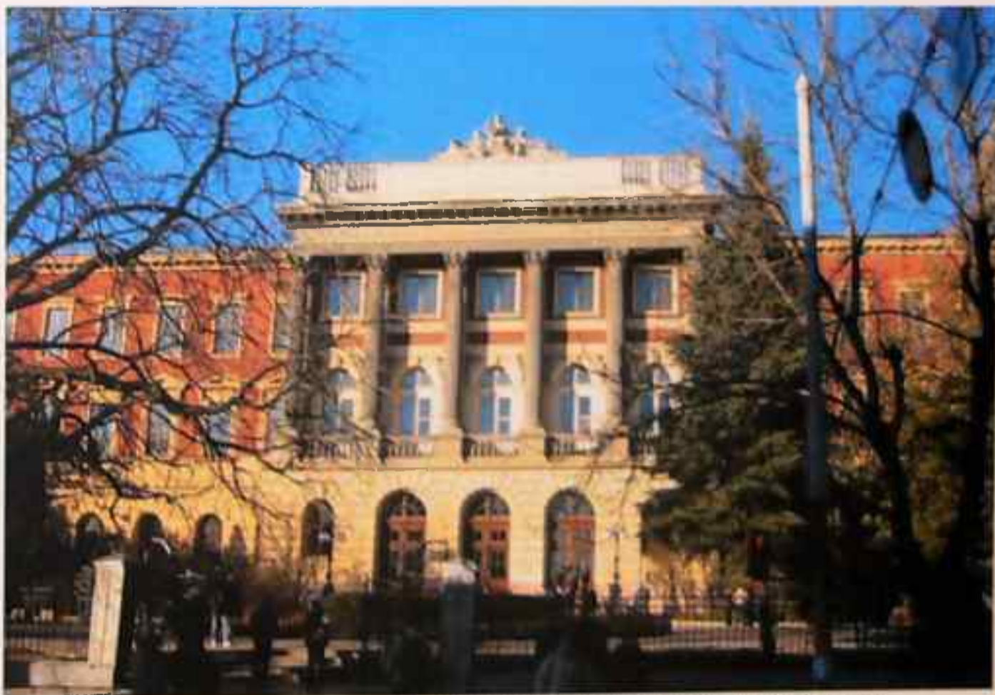
20 GŁÓWNY BLD. POLITECHNIKI LWOWSKIEJ, BUDOWANY W 1877 R.
